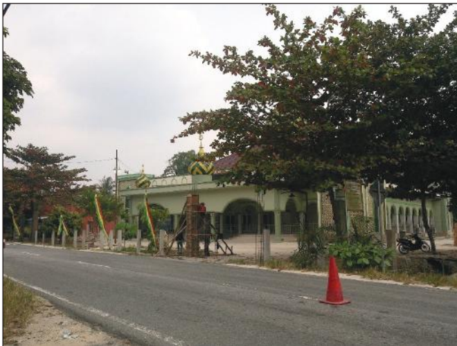
Gambar 5.45 Kondisi jalan di Desa Pantai Cermin
