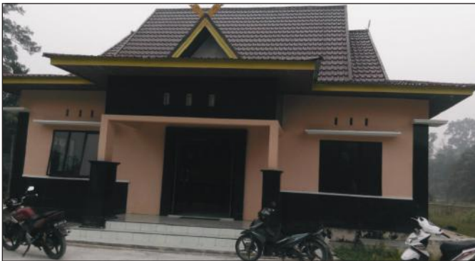
Gambar 5.74 Kantor Desa Muara Bungkal
