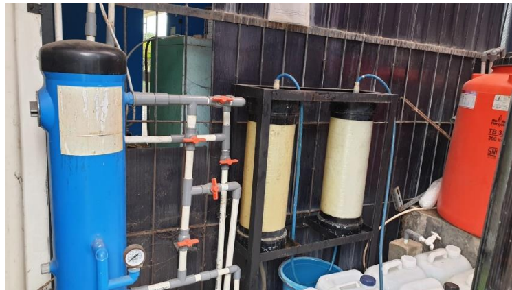
Gambar 9. Alat untuk Pemurnian Air Hujan
