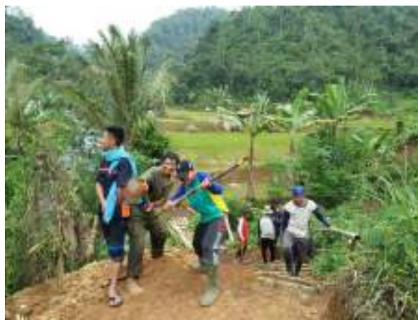
Gambar 4. 11 Memperbaiki Jalur Trekking (Sumber: Facebook Pokdarwis Ciwaluh)
